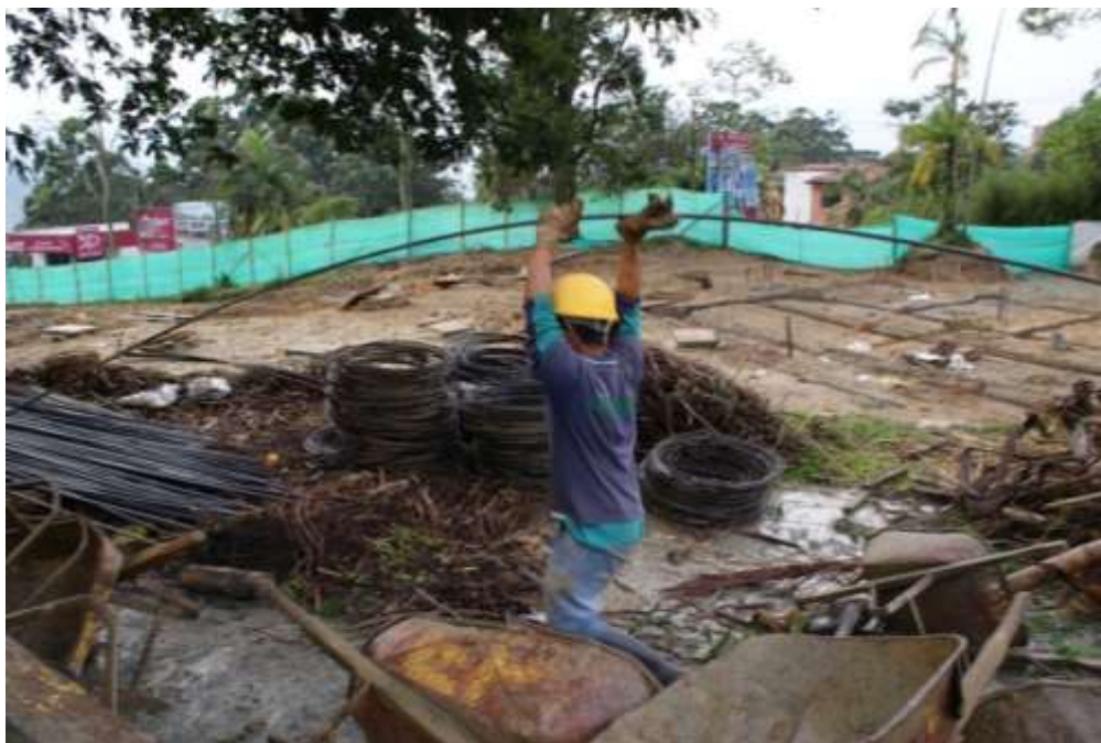
Figura 2 Transporte de acero en la obra 3G. Fotografía tomada por David Restrepo Mora en febrero de 2011.
