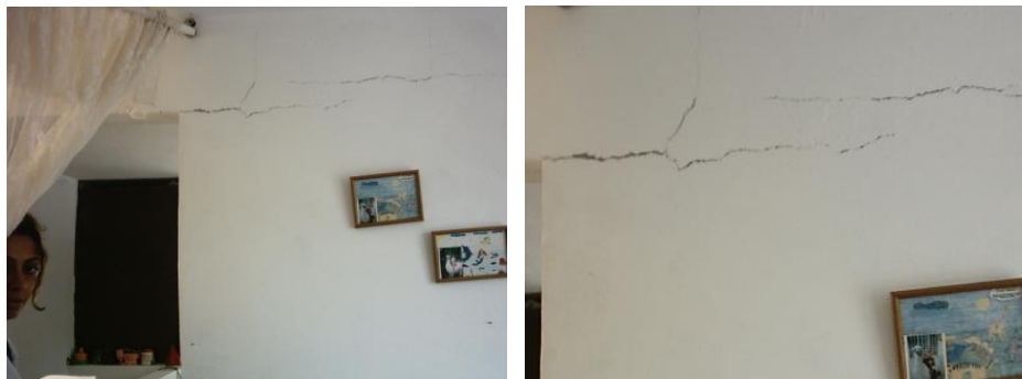
Ilustración 2 : Grietas debido a la dilatación de la losa de cubierta
