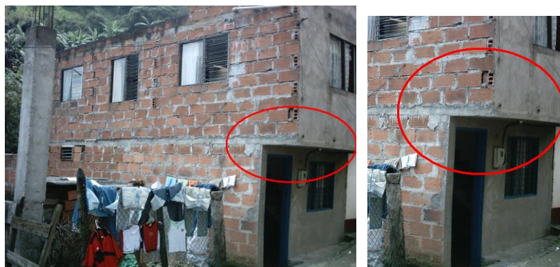
Ilustración 1 : Irregularidad en planta (desplazamiento en los planos de acción)
