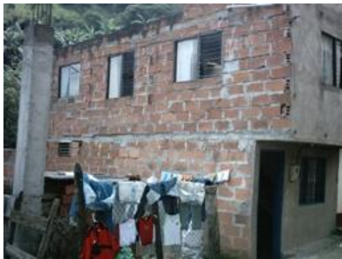
Ilustración 7 : Vista lateral de la vivienda
