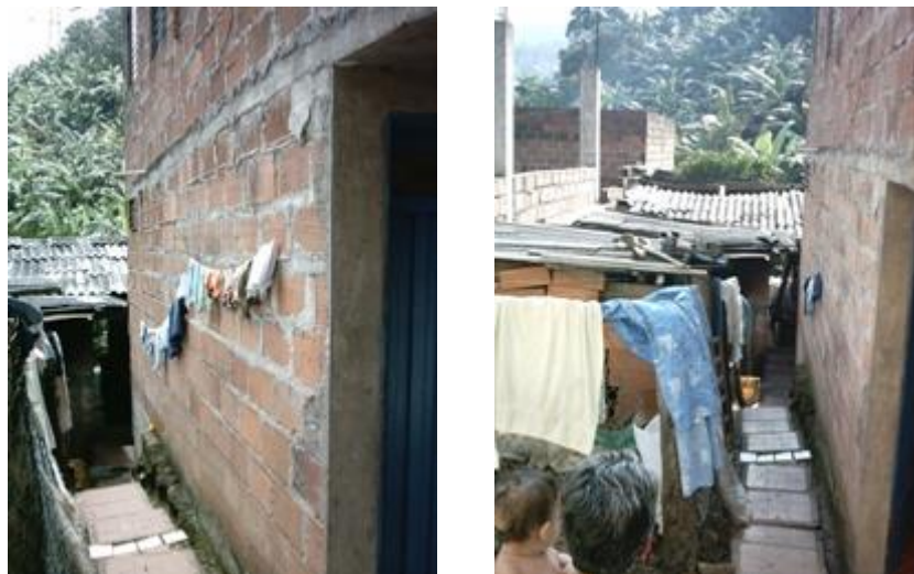
Ilustración 6 : Muro lateral de la vivienda
