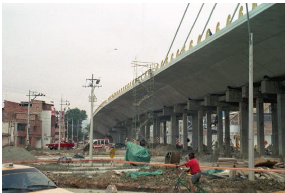
Figura 18, 19. Estructura provisional en concreto para soporte de superestructura
