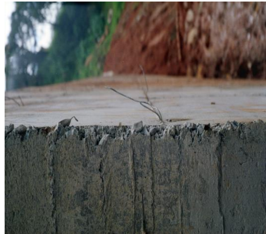
Figura 33, 34. Fisura en la placa deportiva de baloncesto.
