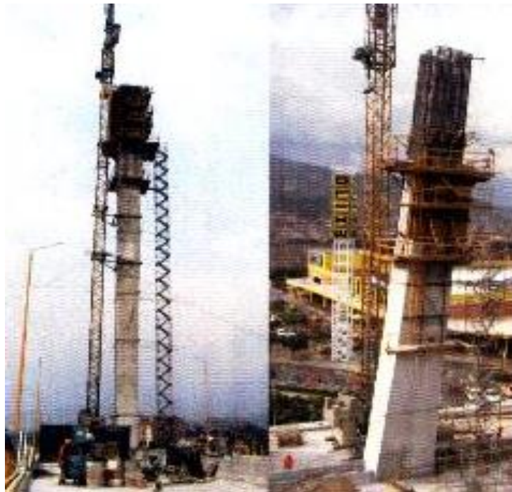
Figura 16. Detalle de la construcción del pilono mediante encofrado trepante.
