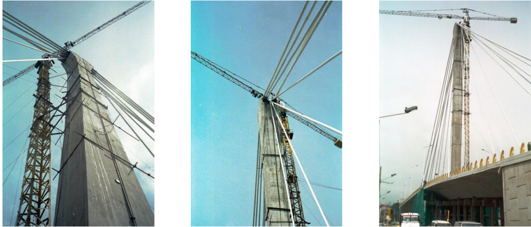
Figura 22, 23, 24. Detalle de silleta, pilono y cableado.
