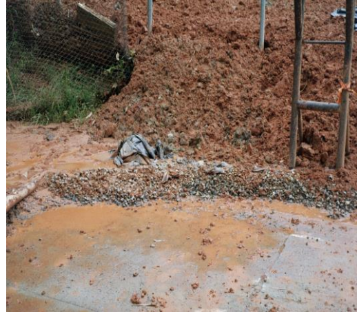
Figura 31, 32. Problema original, fisuración de la placa deportiva del Liceo, debido al desbordamiento de la quebrada La Ayura.
