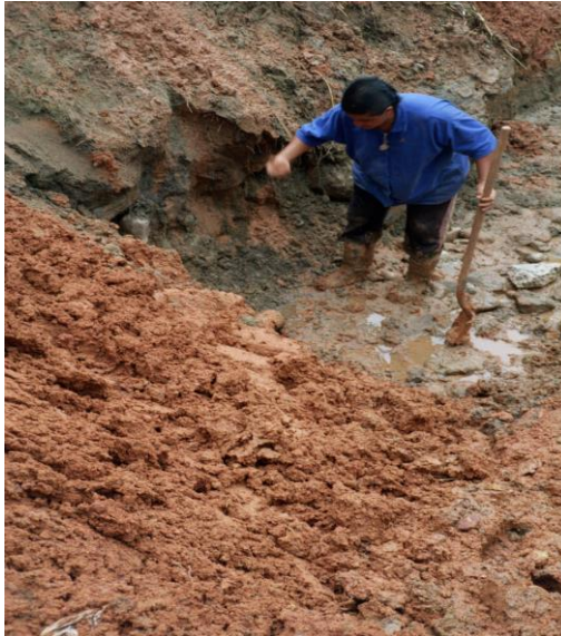
Figura 30. Material del derrumbe ocasionado por el desbordamiento de la quebrada La Ayura.
