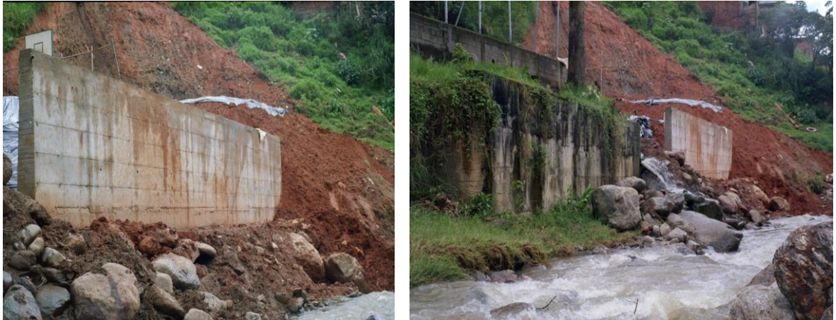
Figura 36. Muro de contención terminado, desviación provisional de la quebrada La Ayura. (Izquierda)
