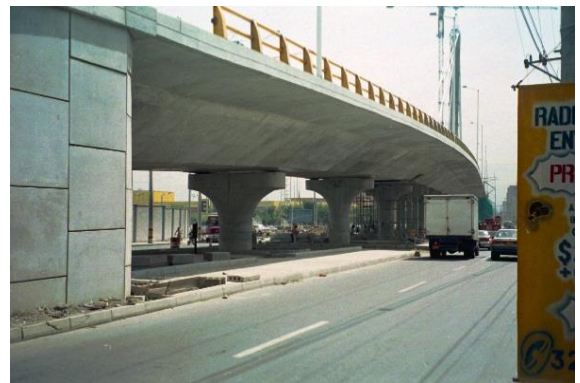
Figura 20, 21. Pilas de apoyo de la superestructura. Costado sur del puente.
