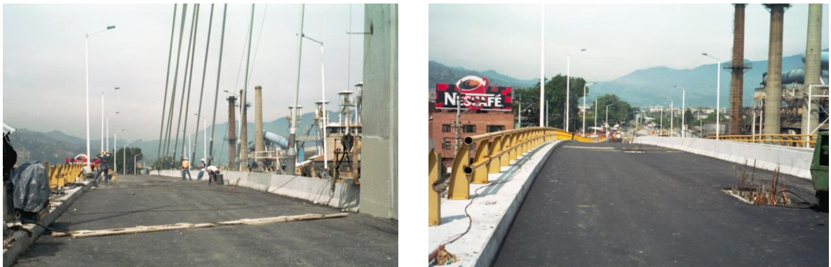
Figura 25, 26, 27, 28, 29. Colocación de la carpeta asfáltica en el puente sobre la Avenida Las Vegas.
