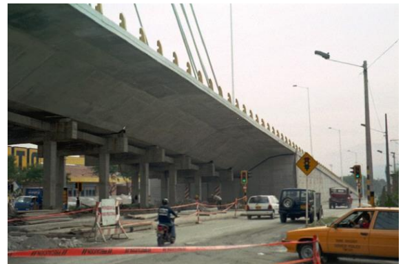
Figura 18, 19. Estructura provisional en concreto para soporte de superestructura
