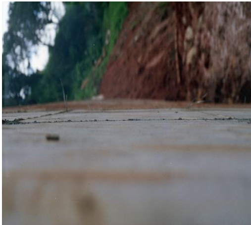
Figura 33, 34. Fisura en la placa deportiva de baloncesto.
