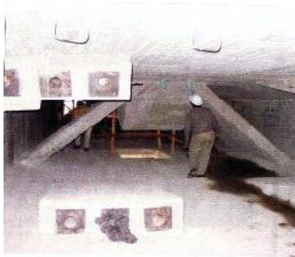
Figura 15. Viga cajón. Detalle de anclaje de cables para tensado del tablero
