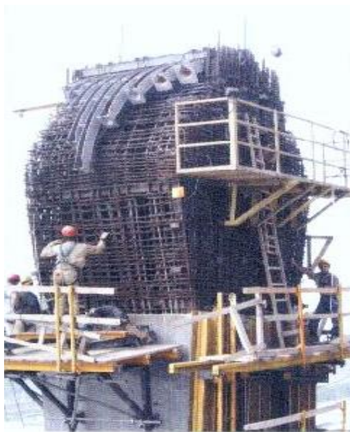
Figura 17. Detalle de armado de la silleta
