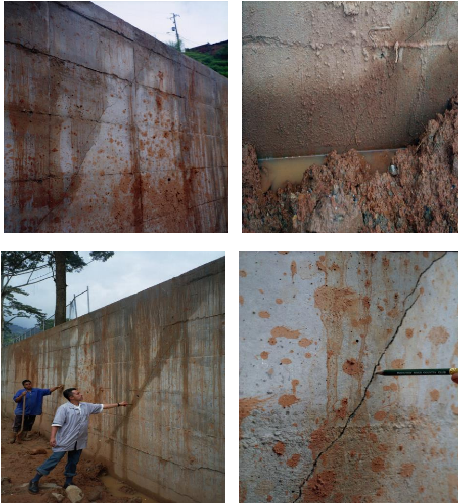
Figura 39, 40, 41, 42. Fisura en el muro de contención, filtración de agua hacia el muro. Ver tamaño de la fisura.
