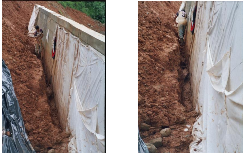
Figura 43, 44. Muro de contención ya terminado cubierto con plástico para protegerlo del agua. Construcción de brecha para hacer lleno en piedra, para que funcione de contrapeso.
