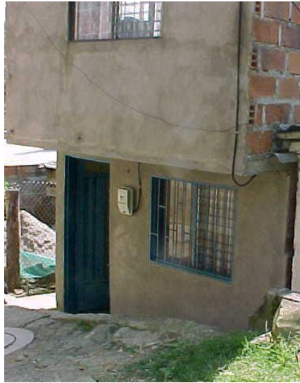
Foto No. 1 Vista Frontal de la Edificación.
