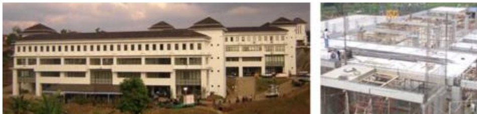
Figura 2-3. Concejo Municipal de Cimahi (Indonesia). Izquierda: Edificio terminado. Derecha: Instalación de elementos prefabricados (Wijanto & Andriono, 2008).
