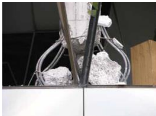
Figura 2-32. Falla en columnas por detallado sísmico inadecuado (Ghosh & Cleland, 2010).
