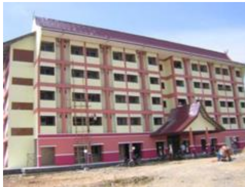
Figura 2-5. Edificación residencial construida con prefabricados en Indonesia (Wijanto & Andriono, 2008).
