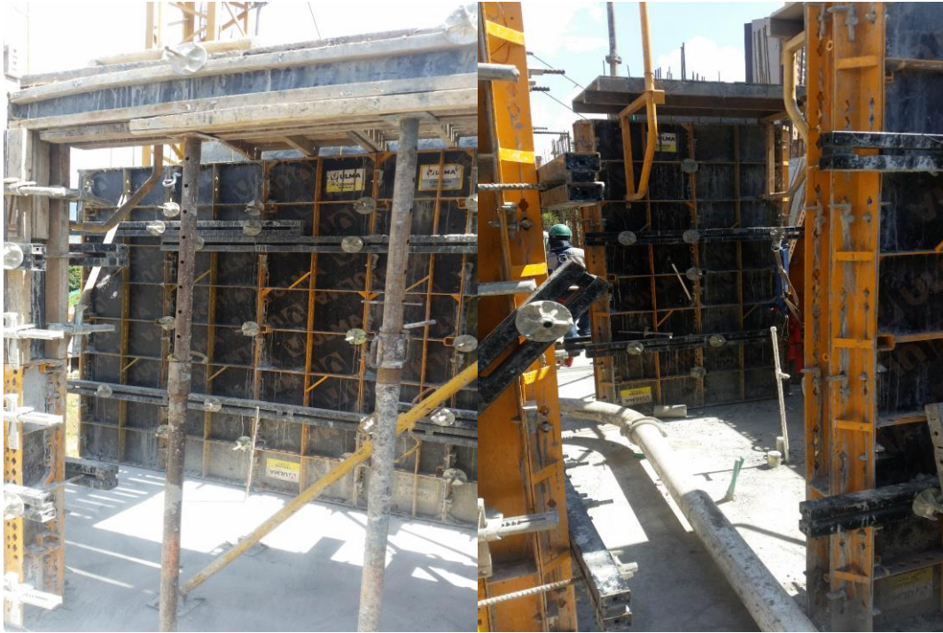
Ilustración 10 Encofrado de muros
