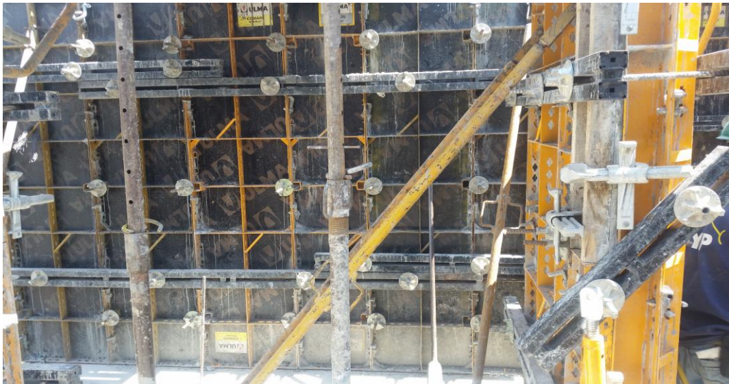
Ilustración 10 Encofrado de muros
