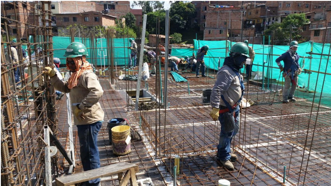
Ilustración 8 Acero de losa
