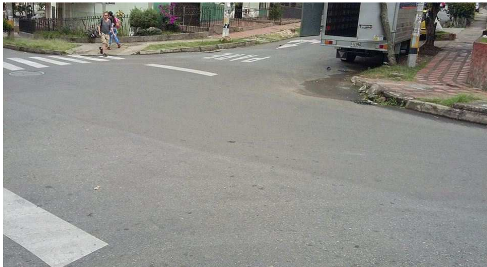
Figura 2: Falta de continuidad aceras. Imagen propia.
