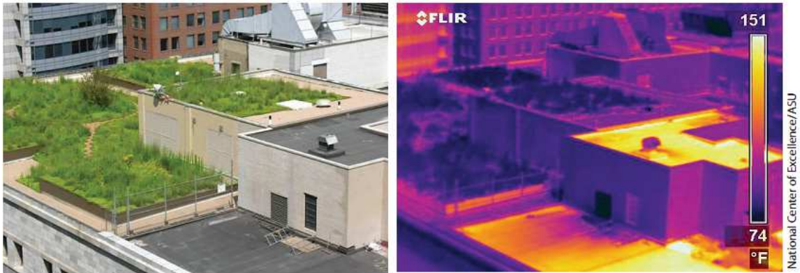
Ilustración 36 Imagen térmica comparando un techo verde y uno techo común (EPA, 2011)
